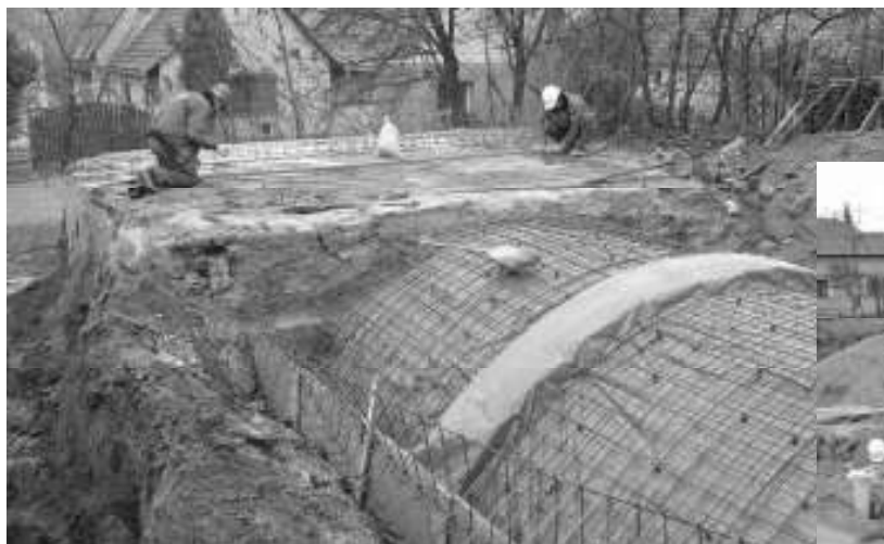
A pince földém betonozása
